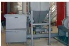
Bac à cendres centralisé d'une capacité de 60 à 1250 litres (selon la taille de l'installation), également disponible jusqu'à 3 m<sup>3</sup> (construction spécifique)
