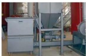
Bac à cendres centralisé d'une capacité de 60 à 1250 litres (selon la taille de l'installation), également disponible jusqu'à 3 m3 (construction spécifique)
